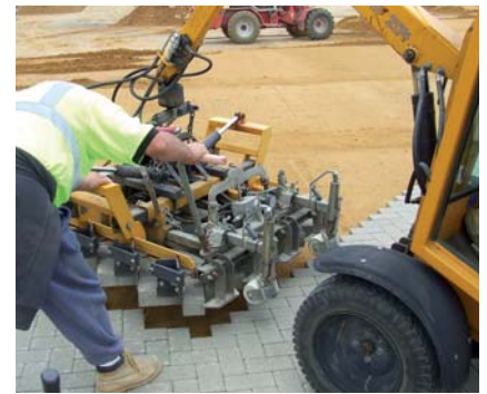
HVZ Fischgrät 45 Grad, für große Flächen im Fischgrätverband eine geniale Lösung. Dieser Zangentyp greift die in 45°-paketierten Verlegeeinheiten und ermöglicht ein Verlegen ohne manuelles Nachlegen von Steinen.
